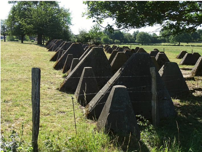
Biotopverbund im Westen - der Westwall im Stadtgebiet von Aachen (2017) Fotograf/Urheber: Manfred Aletsee
