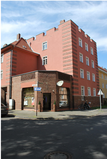
Die Germaniasiedlung in Köln-Höhenberg wurde zwischen 1920 und 1928 erbaut. Bei der Fassadengestaltung ist der Wechsel zwischen Backsteinornamenten und Putzflächen sowie die Verwendung kräftiger Farbanstriche typisch für die expressionistische Formensprache der Weimarer Zeit (2014). Fotograf/Urheber: Martina Gelhar
