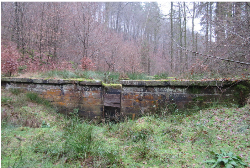
Dammmauer am abgelassenen Woogbecken Fotograf/Urheber: Matthias Dreyer
