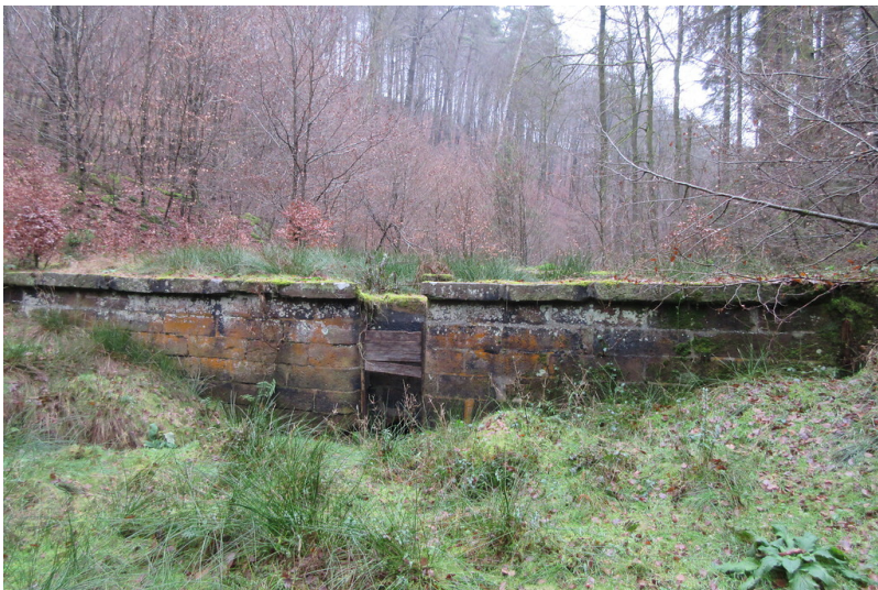
Dammmauer am abgelassenen Woogbecken Fotograf/Urheber: Matthias Dreyer
