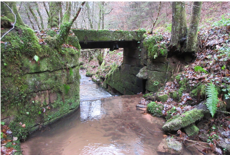
Absperrbauwerk am Wintertaler Woog am Breitenbach (2018) Fotograf/Urheber: Matthias C.S. Dreyer
