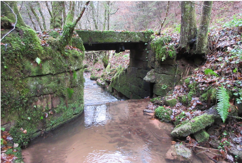
Absperrbauwerk am Winterthaler Woog am Breitenbach (2018) Fotograf/Urheber: Matthias C.S. Dreyer
