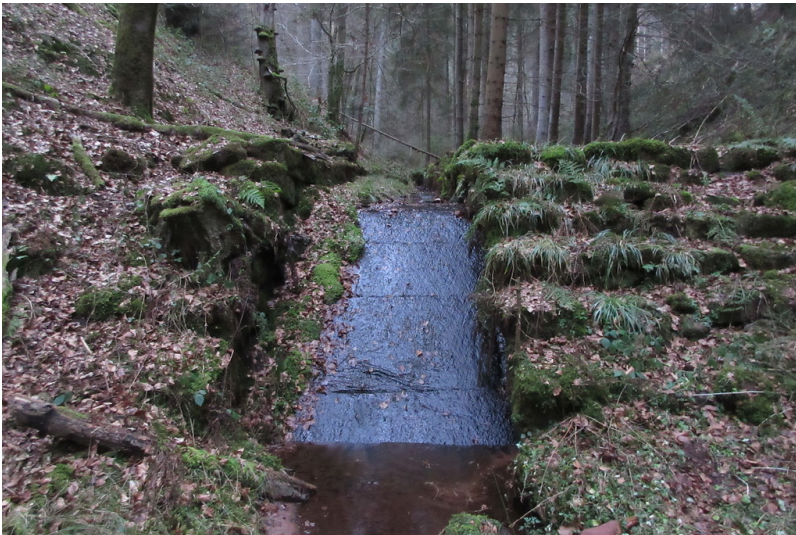
Sohlrampe am Finsterbreitenbach (2018) Fotograf/Urheber: Matthias C.S. Dreyer
