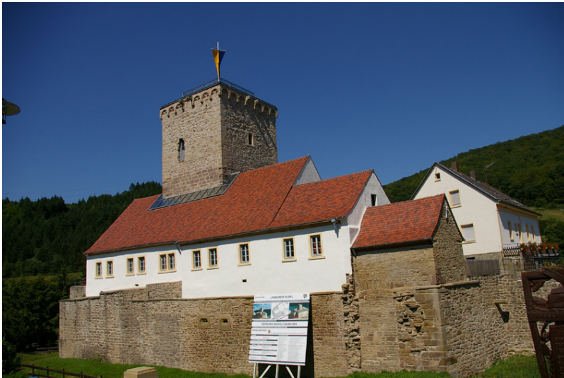
Gesamtansicht von Südwesten Fotograf/Urheber: Silke Kretzschmar
