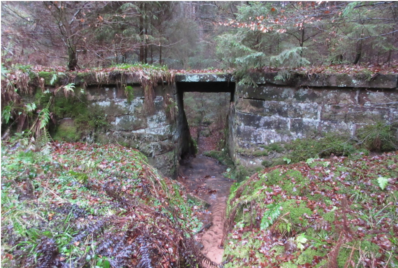
Absperr- und Auslaufbauwerk am Rumpelswoog am Breitenbach (2018) Fotograf/Urheber: Matthias C.S. Dreyer
