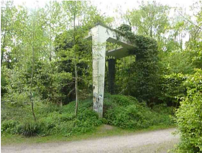
Steinbrecher im ehemaligen Kalksteinbruch Grube 7 in Haan (2019) Fotograf/Urheber: Silke Junick
