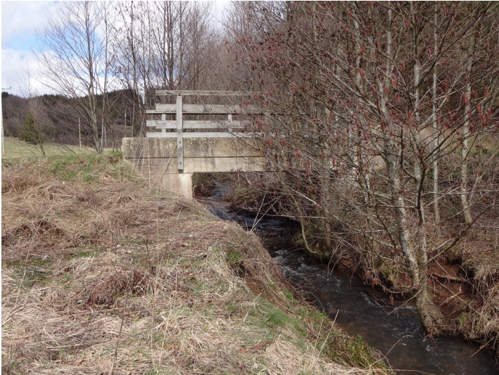
Blick auf die Brücke über den Krekeler Bach, der in den Manscheider Bach mündet (2019). Fotograf/Urheber: Jennifer Thelen
