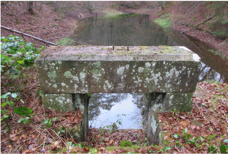
Damm und Auslaufbauwerk am Kleinlegelbacher Woog am Legelbach (2018) Fotograf/Urheber: Matthias C.S. Dreyer
