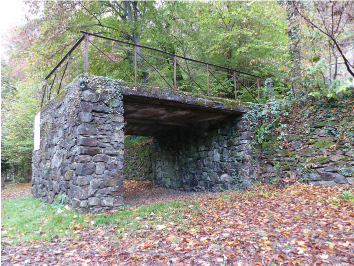
Laderampe des Steinbruchs bei Wietsche im Murbachtal (2018) Fotograf/Urheber: Maximilian Lörch
