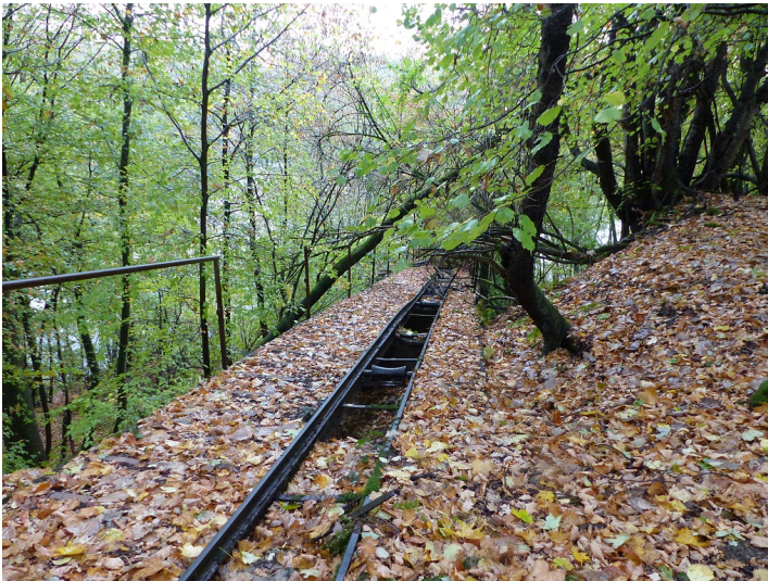
Überreste des Förderbandes im Hilgener Ziegeleilochs in Wermelskirchen (2018) Fotograf/Urheber: Maximilian Lörch
