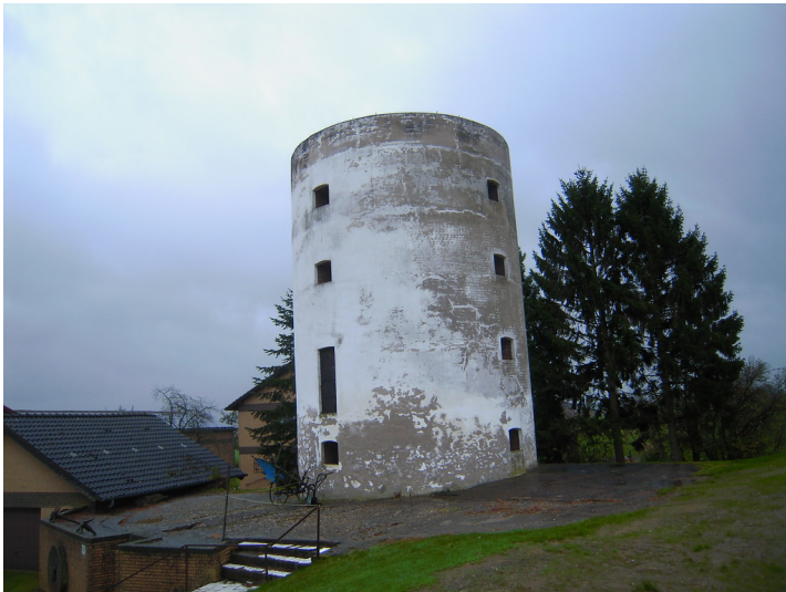
Alter Wehrturm, später Windmühle Rosau (2015) Fotograf/Urheber: Hans-Michael Altemüller
