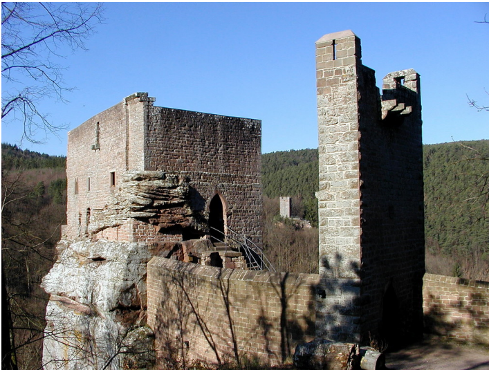
Pallas und neuere Schildmauer von Südosten Fotograf/Urheber: Jürgen Keddigkeit
