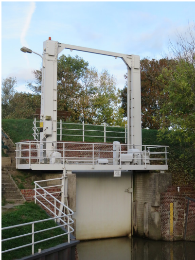
Frontansicht der Verlathschleuse in Borsfleth (2018) Fotograf/Urheber: Frank Andraschko
