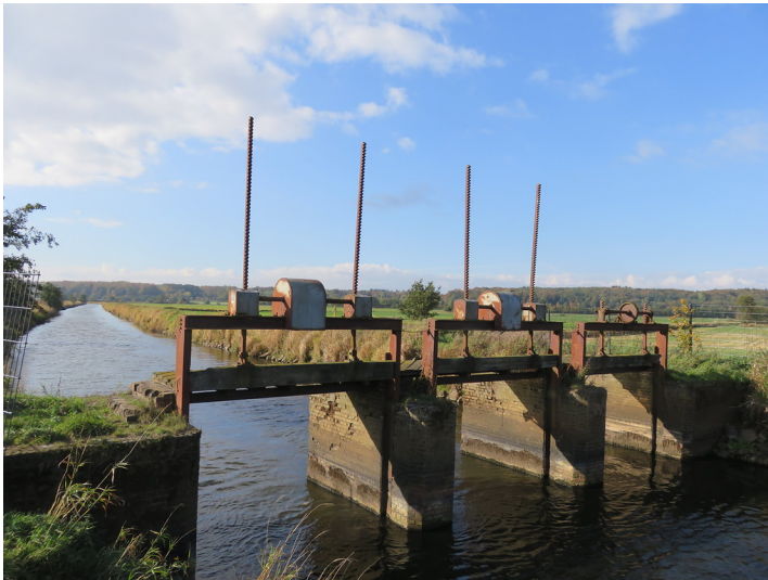
Stauwehr Störkathen (2018) Fotograf/Urheber: Frank Andraschko
