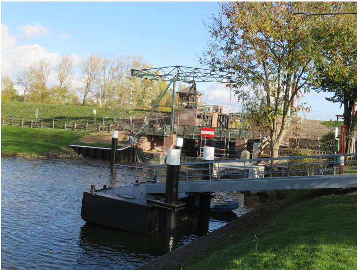
Schleuse und Klappbrücke Kasenort (2018) Fotograf/Urheber: Frank Andraschko
