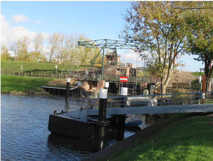
Schleuse und Klappbrücke Kasenort (2018) Fotograf/Urheber: Frank Andraschko
