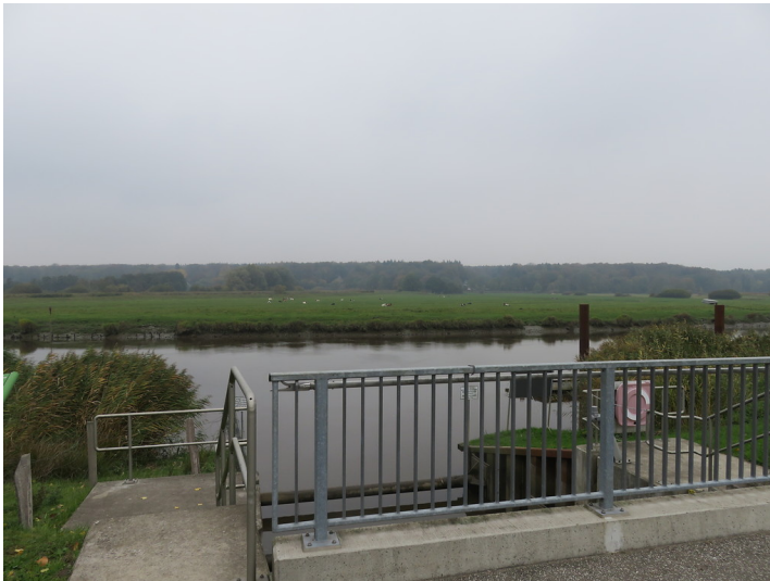
Breitenburger Kanal und Schleuse (2018) Fotograf/Urheber: Frank Andraschko
