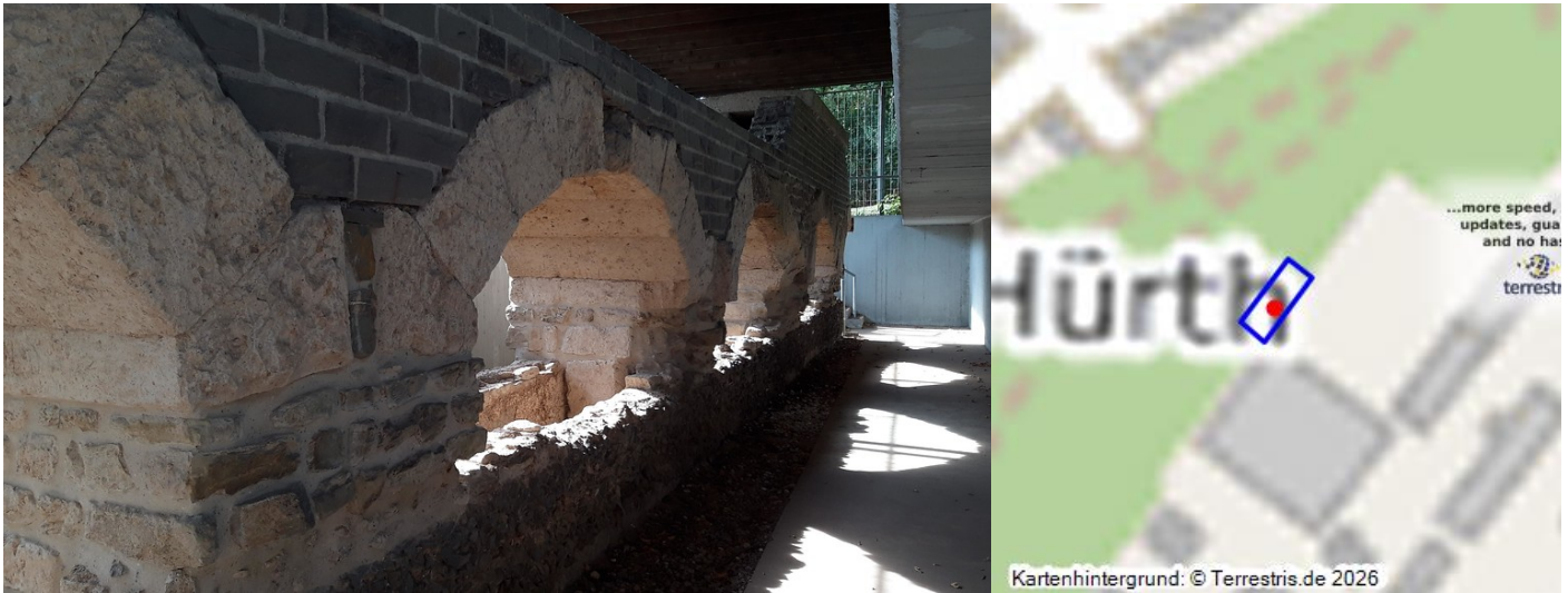
Aquädukt der Römischen Eifelwasserleitung in Hürth (2018) Fotograf/Urheber: Ulrich Stevens
