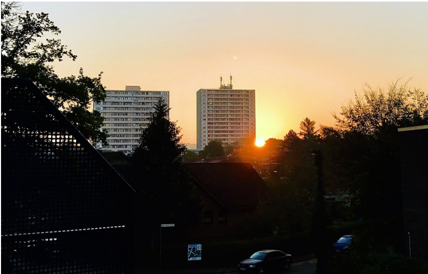
Wohnhochhäuser in Erfstadt-Liblar (2018), rechts im Bild das Gebäude Theodor-Heuss-Straße 20, links Zum Renngraben 8. Fotograf/Urheber: Dorothee Müller
