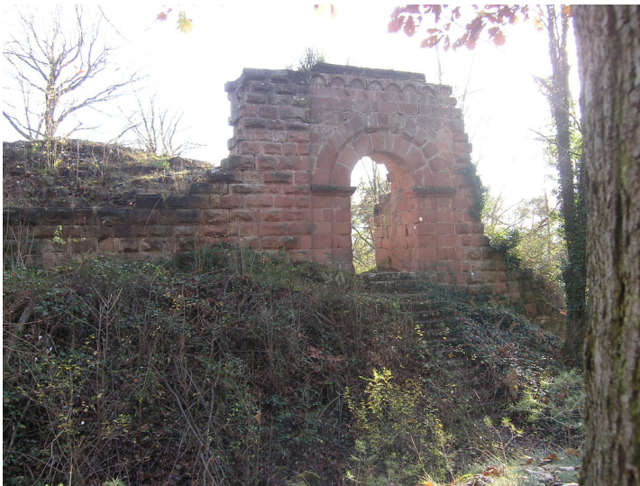
Das Kellergeschoss auf der Westseite der Burgruine Schlosseck (2006). Fotograf/Urheber: Dieter Barz
