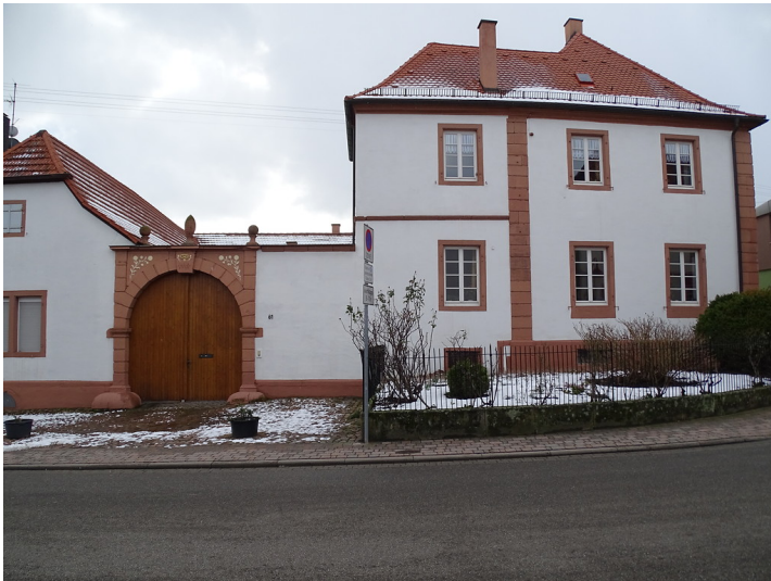
Barocke Hofanlage in Alsterweiler (2018) Fotograf/Urheber: Matthias C.S. Dreyer
