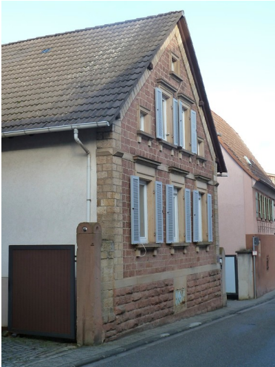
Bauernhaus Allmaras in Alsterweiler (2018) Fotograf/Urheber: Matthias C.S. Dreyer
