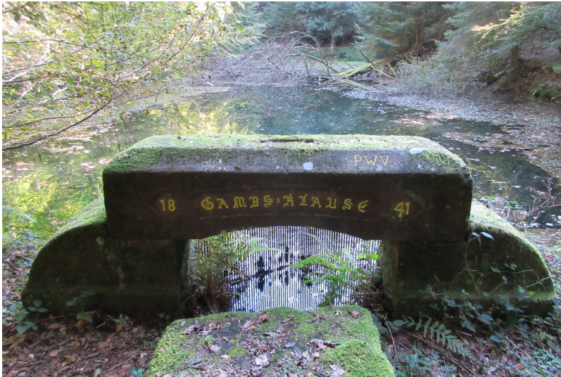
Wasserbauwerk Gambs-Klausen im Pfälzerwald (2018) Fotograf/Urheber: Matthias C.S. Dreyer
