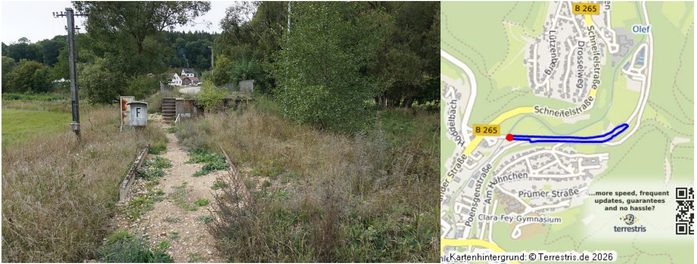
Schleiden-Höddelbusch, Bahnhof (2022). Verladerampe Fotograf/Urheber: Claus Weber
