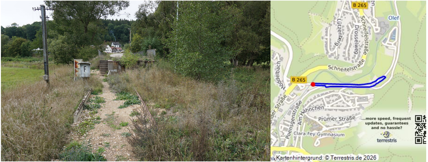
Schleiden-Höddelbusch, Bahnhof (2022). Verladerampe Fotograf/Urheber: Claus Weber
