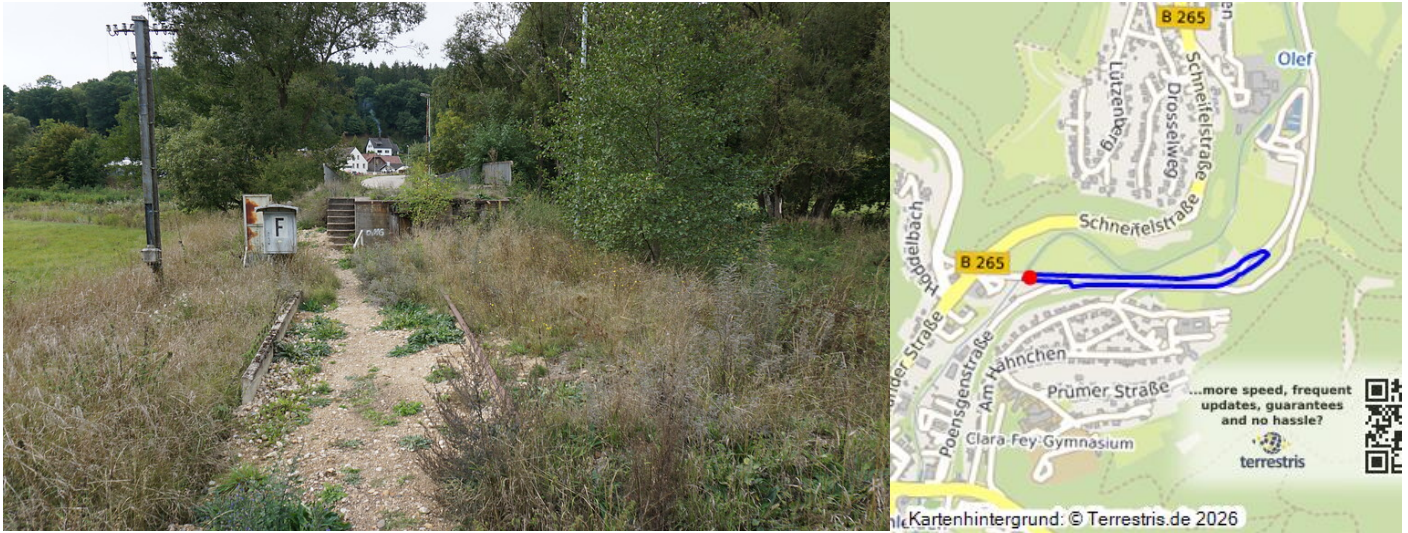
Schleiden-Höddelbusch, Bahnhof (2022). Verladerampe Fotograf/Urheber: Claus Weber
