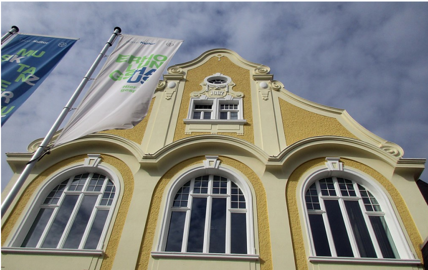
Oberer Bereich der östlichen Fassade des Bayer Erholungshauses in Leverkusen-Wiesdorf (2018) Fotograf/Urheber: Franz-Josef Knöchel
