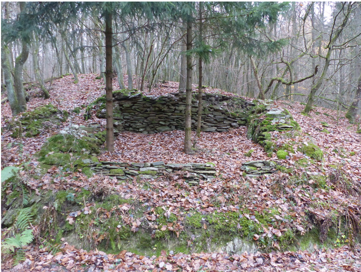
Reste des Limeswachturms Wp 4/18 "Am Ameisenkopf" westlich von Friedberg-Ockstadt (2018) Fotograf/Urheber: Hans Szédeli
