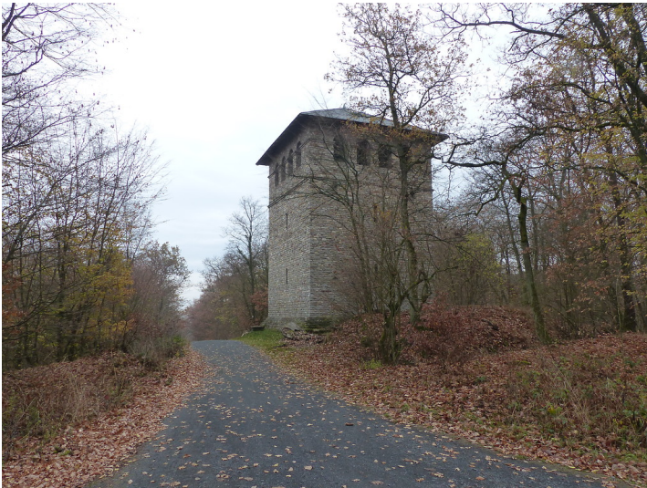
Rekonstruierter Limeswachturm Wp 4/16 "Gaulskopf" westlich von Friedberg-Ockstadt (2018) Fotograf/Urheber: Hans Szédeli
