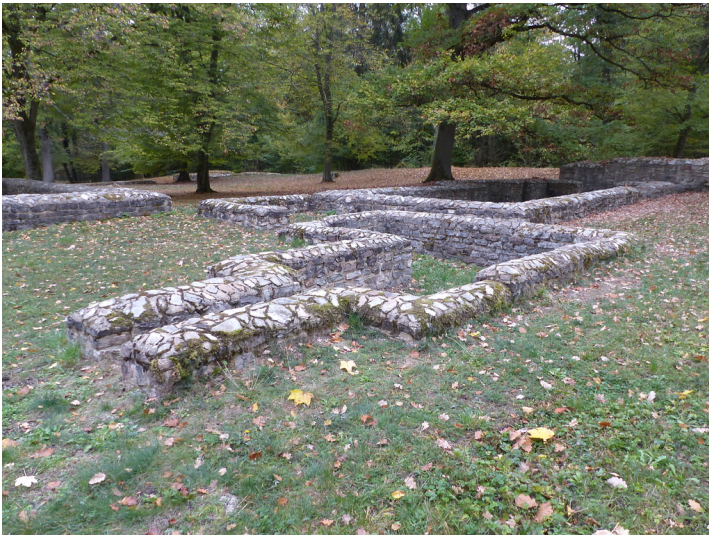
Gebäude im Nordosten des Kastell Kapersburg (2018) Fotograf/Urheber: Hans Szédeli
