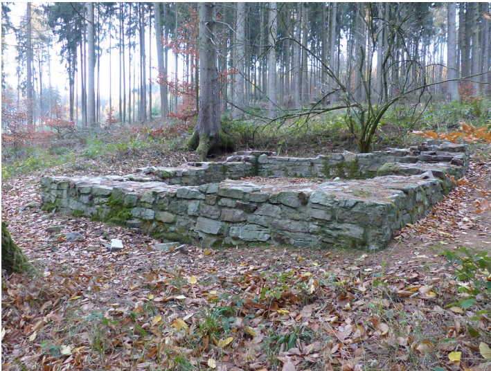
Limeswachturm Wp 3/69 "Am Bennerpfad" nördlich von Bad Homburg-Dornholzhausen (2018) Fotograf/Urheber: Hans Szédeli
