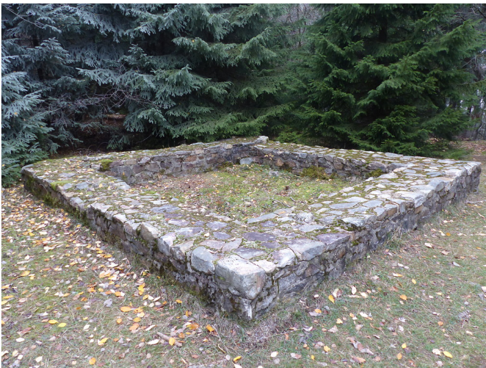
Rekonstruierter Grundriss des aus Stein errichteten Wachturmes 3/55 "Auf dem Klingenkopf" südlich von Neu-Anspach-Anspach (2018) Fotograf/Urheber: Hans Szédeli
