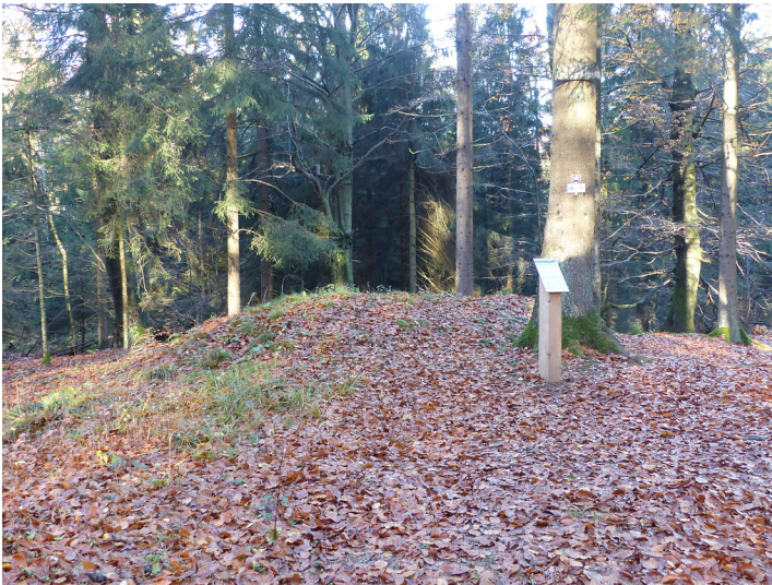
Limeswachturm Wp 3/43 "Auf der Weststeite der Emsbachschlucht" östlich von Glashütten (2018) Fotograf/Urheber: Hans Szédeli
