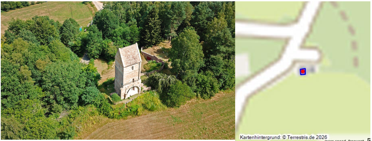
Luftaufnahme des Turmes am Aschbacherhof. Die Grundmauern der ehemaligen St. Blasius Kirche liegen westlich des Turmes (2018). Fotograf/Urheber: Andreas Fröhlich
