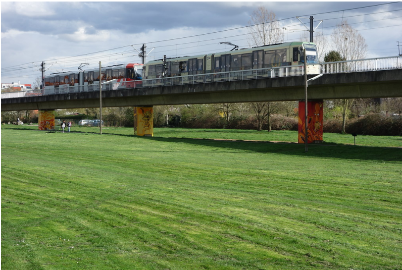
Die Straßenbahnlinie der "Gürteltrasse" verläuft im Abschnitt parallel der Eckewartstraße in Köln-Mauenheim als Hochbahn über eine öffentliche Grünfläche (2016). Fotograf/Urheber: Martina Gelhar
