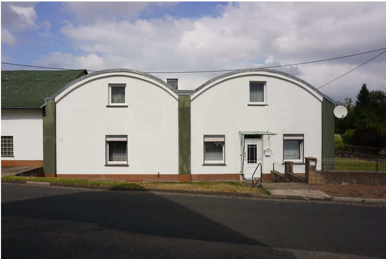
Bleibergbau am Tanzberg in Keldenich, ehemaliges Maschinenhaus (2018). Fotograf/Urheber: Claus Weber
