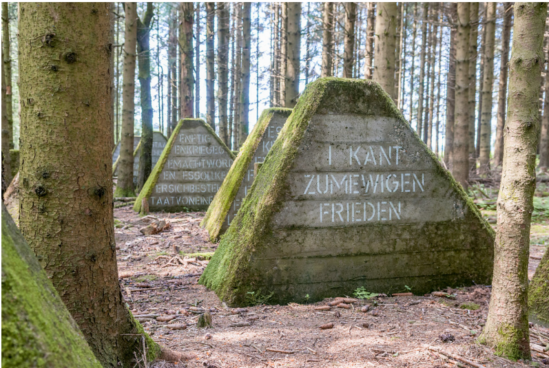
Hellenthal, Hollerather Knie. Panzersperre des Westwalls, Höckerlinie (2018) Fotograf/Urheber: Marcel Zanjani
