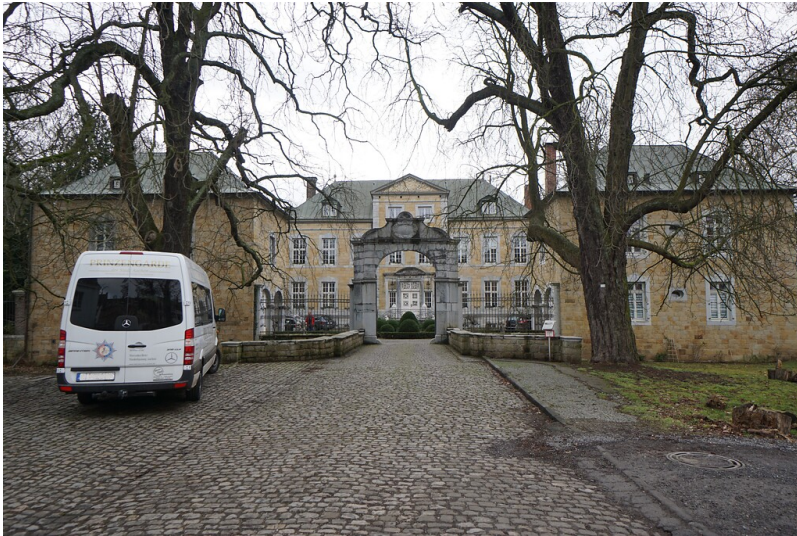
Gepflasterte Zufahrt zum Kupferhof Rosental über Brücke mit steinernem Tor (2019) Fotograf/Urheber: Katrin Probst
