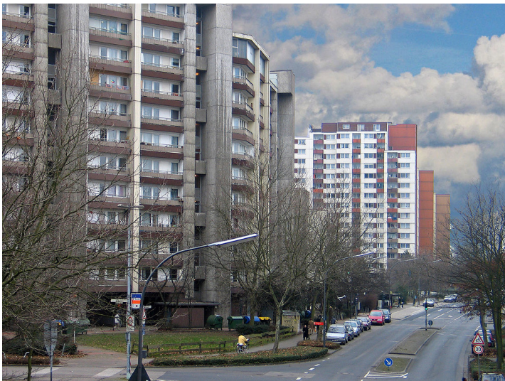
Wohnblocks in Köln-Finkenberg (2008). Fotograf/Urheber: Superbass
