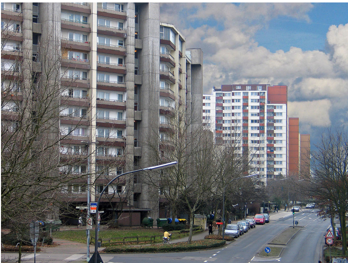
Wohnblocks in Köln-Finkenberg (2008). Fotograf/Urheber: Superbass
