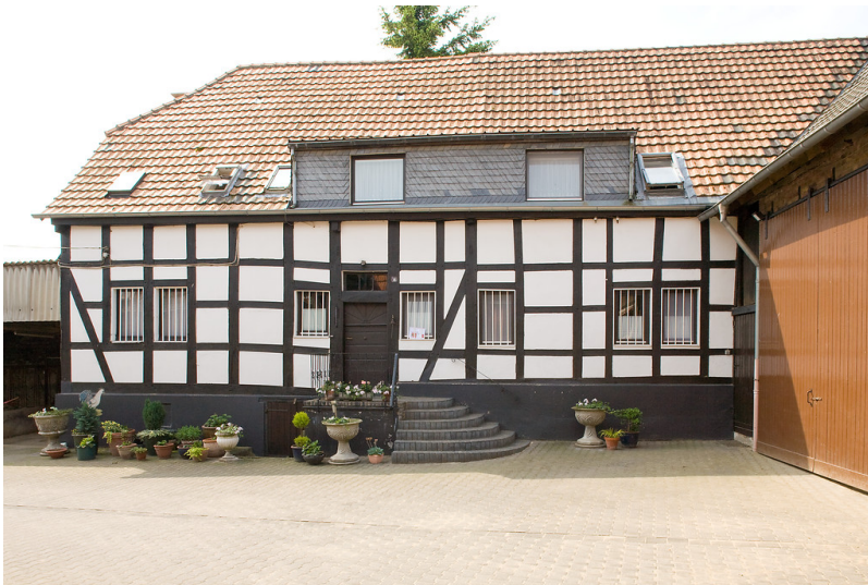
Kerpener Obermühle, Ansicht vom Hof (2009) Fotograf/Urheber: Nicole Schäfer
