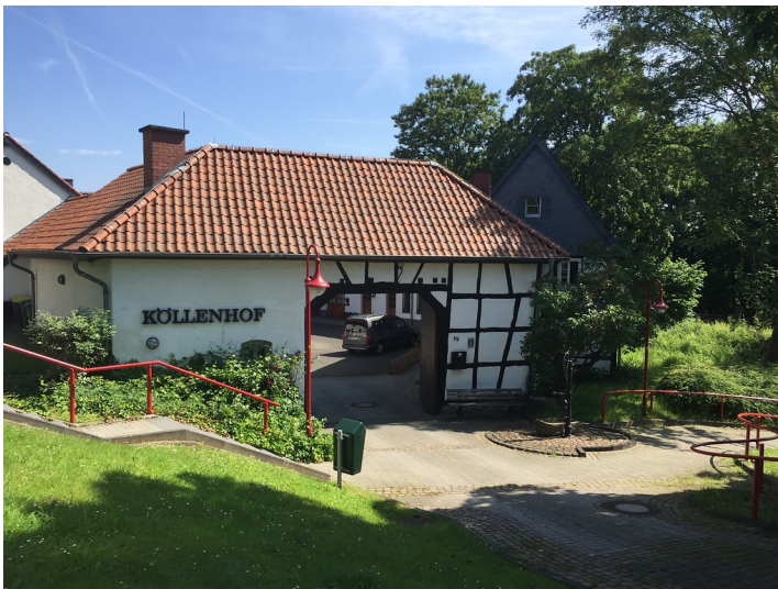
Eingangsbereich des Kollenhofs in Ließem, Gemeinde Wachtberg (2018). Fotograf/Urheber: Clarissa Pönisch
