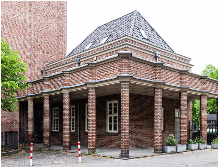
Ehemaliges Eingangs-, Verwaltungs- und Hausmeistergebäude der Theodor-Heuss-Realschule in Köln-Sülz (2021) Fotograf/Urheber: Sebastian Löder
