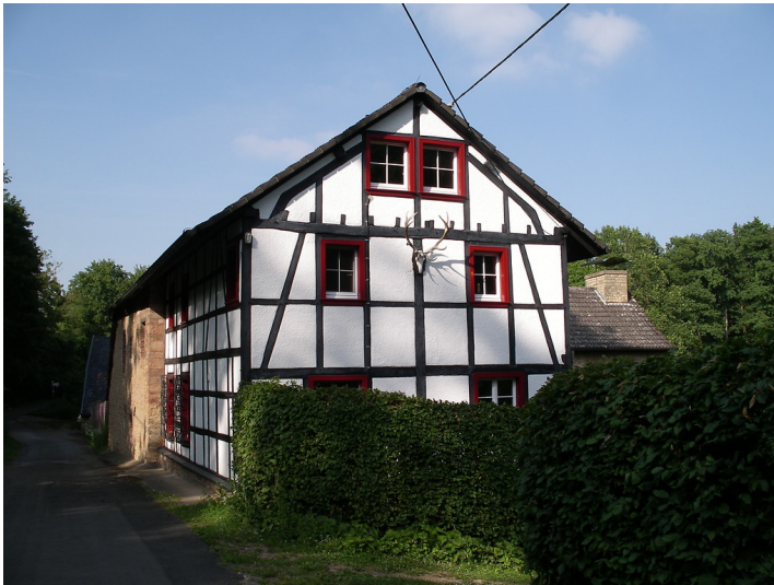
Wohnhaus der Eickser Mühle (2018) Fotograf/Urheber: Annette Schwabe
