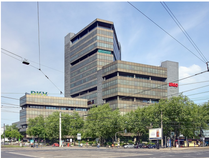
Das Hochhaus der Hauptverwaltung der Deutsche Krankenversicherung AG, Ecke Aachener Straße / Gürtel in Köln-Braunsfeld (2011) Fotograf/Urheber: Raimond Spekking
