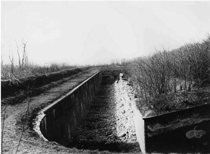
Historische Aufnahme des Frontgrabens von Fort IV im äußeren Kölner Grüngürtel vor der Schleifung 1920. Fotograf/Urheber: Arbeitsgemeinschaft Festung Köln e.V.
