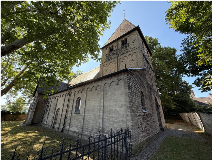
Blick von Norden auf die Kirche Alt Sankt Katharina in Köln-Niehl, auch "Niehler Dömchen" genannt (2025) Fotograf/Urheber: Malte Hennes
