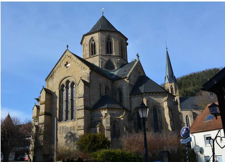
Evangelische Pfarrkirche in Offenbach am Glan, Chor mit drei Apsiden (2019) Fotograf/Urheber: Sonja Kasprick
