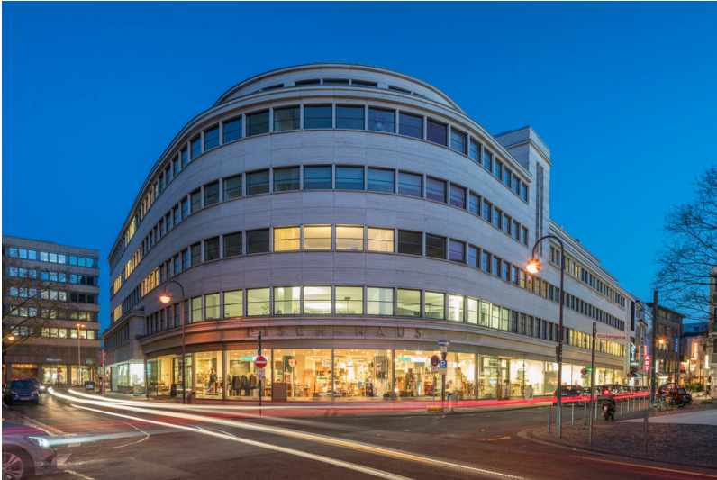
Das Dischhaus in Köln (2018) Fotograf/Urheber: Holger Klaes
