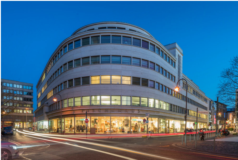
Das Dischhaus in Köln (2018) Fotograf/Urheber: Holger Klaes
