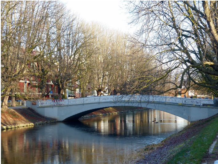
Blick auf eine Brücke über den Clarenbachkanal, auch Lindenthaler Kanal bzw. Kanäle, in Köln-Lindenthal (2016). Fotograf/Urheber: Geolina163
